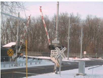
<M-City、交差点設備>
